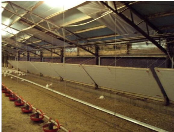
Inlet de túnel
