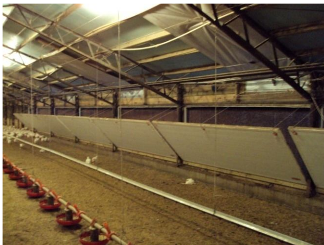
Inlet de túnel
